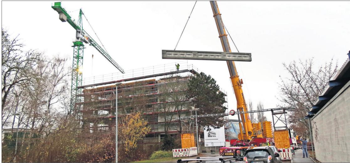
Schlussstein fürs Dach: Am Freitag schwebte ein 46,6 Tonnen schwerer Träger auf der Film-Baustelle ein.
